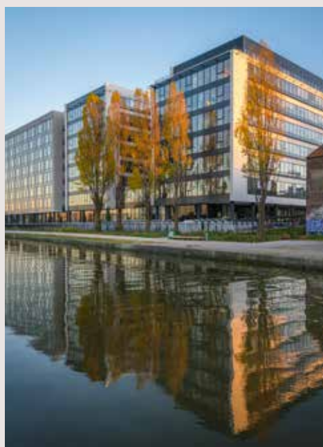
LUMINEM : 18 000 M 2 DE BUREAUX, ► AGENCE LECLERCQ, BNPI ET GA SMART BUILDING. © FRANCK BADAIRE / THOMAS GUYENET
