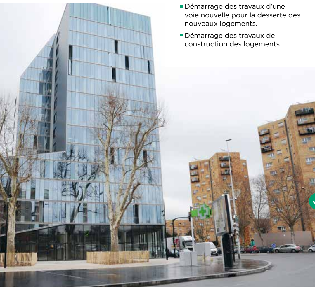
▲ 57 LOGEMENTS SOCIAUX ET 581 M² DE COMMERCE EN REZ-DE-CHAUSSÉE, GAËTANT LE PENHUEL, OPH, AUBERVILLIERS © G. LARVOR
