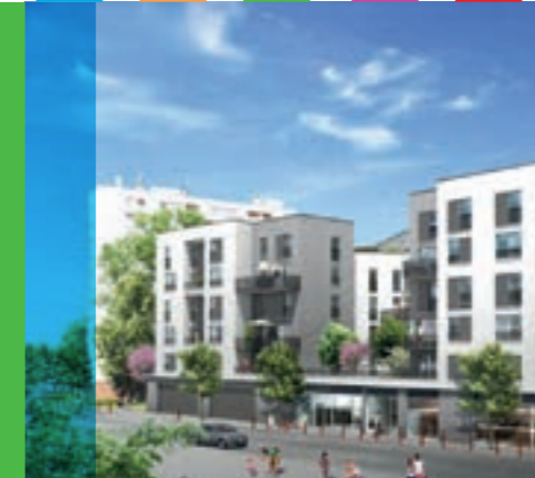
7.4 Architecte : Atelier Castro-Denissof Promoteur : Nexity Programme : 36 logements, commerces et parking de 200 places Livraison : 2016
