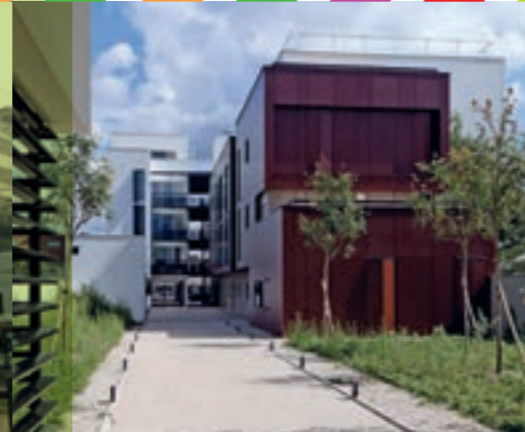
6.2 Architecte : Gemaile Rechak architecte Promoteur : AB Habitat Programme : 32 logements Livré en juillet 2011
