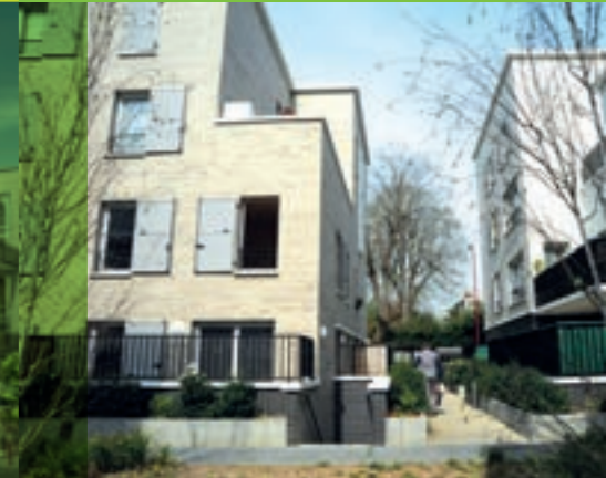
4.1 Architecte : Atelier Castro-Denissof Promoteur : Nexity pour AB Habitat Programme : 81 logements Livré en septembre 2012
