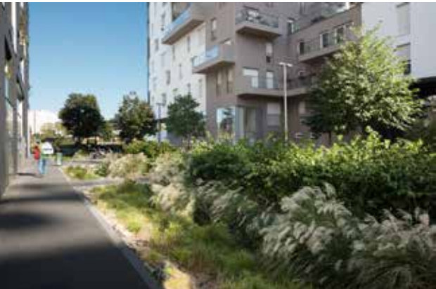
Espace public aux Docks de Saint-Ouen.
