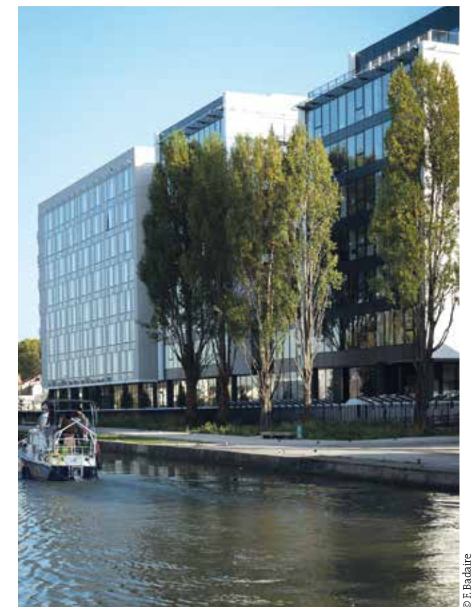
Immeuble de bureau Luminem, Bobigny.
