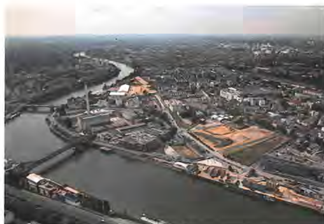
Sur la ZAC d'Ivry-Confluences à Ivry-sur-Seine (Val-de-Marne), la SEM Sadev 94 incite les promoteurs à développer de nouvelles formes urbaines.
