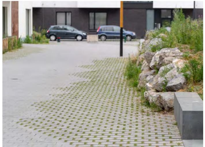
*Revêtement semi-perméable : pavés joints enherbés*
