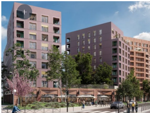
Projet d'Emerige en BRS, rue Pierre Architecte : Vincent Perreira Zac de l'Ecoquartier des Docks à Saint-Ouen-sur-Seine
